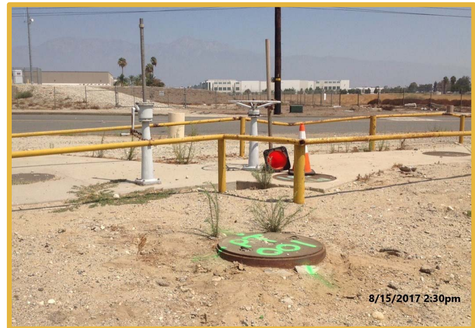
Original Manhole Lid
